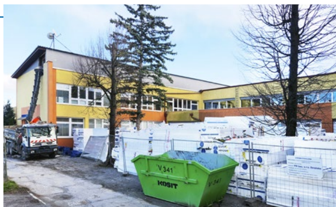
Rekonštrukcia ZŠ Haniska prinesie úsporu energie
