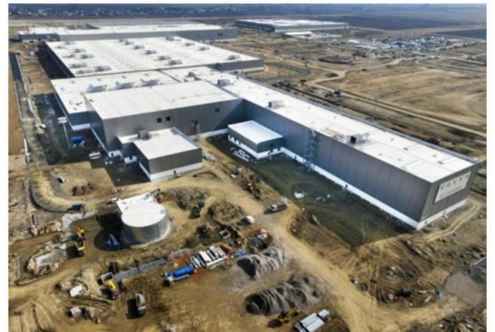
Aktuálny stav na stavbe, marec 2025
